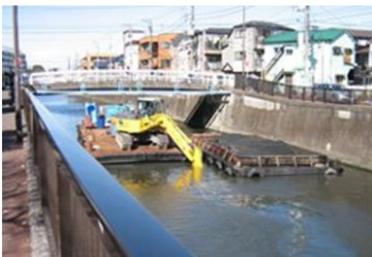
写真 2.4 バックホウによる浚渫状況
