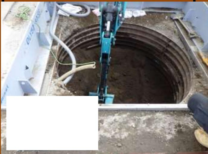
3.掘削、土留め(ライナープレート)組み立てを繰り返し、掘り進める
