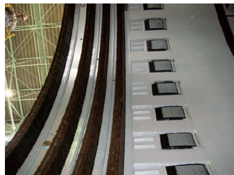
写真-5 シールドテール内エアバック
