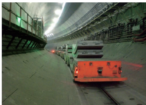
写真-1 セグメント搬送台車 (タイヤ式)
