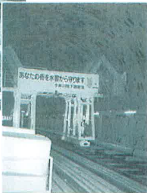
▶トンネルの内側はセグメントというブロックが隙間なく張りつけられていく
