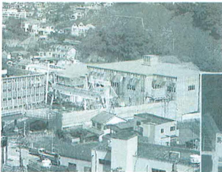
◀今井川地下鉄駅地の工事基地では、周辺の地帯への影響に配慮した環境保全対策に万全を期している
