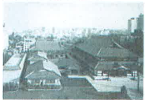
▲高輪変電所の上に建つ黒野山東京別院
